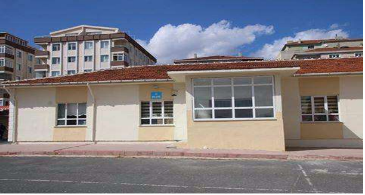
(FEVZİ PAŞA İLKÖĞRETİM OKULU MANTOLAMA ÇALIŞMASI)
