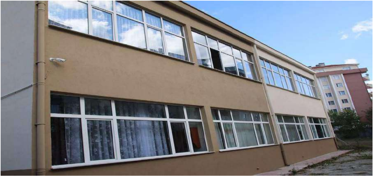
(RECEP ARİF GABRALI İLKÖĞRETİM OKULU MANTOLAMA ÇALIŞMASI)
