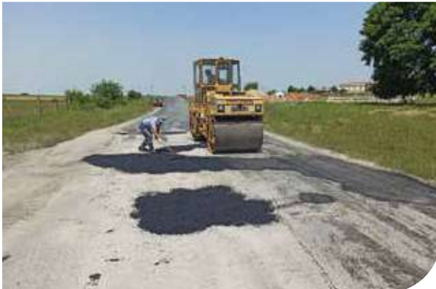
Asfalt Yama ve Tamirat Yapım İşleri
