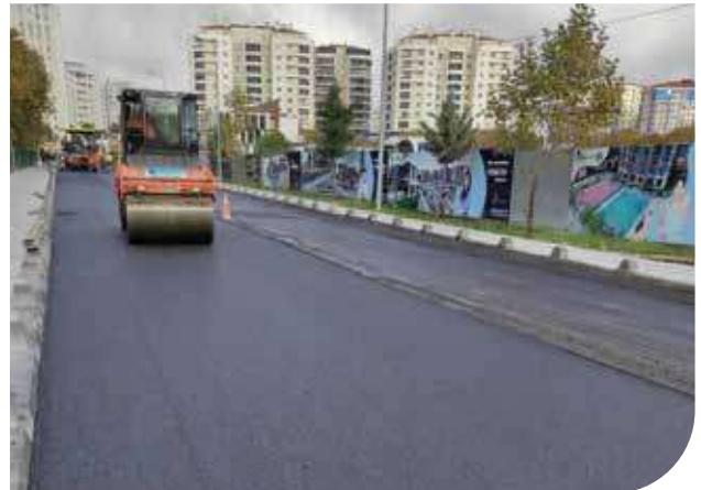
Melisa Sokak Asfalt Yol
