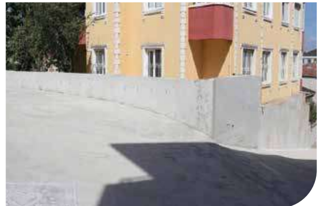
İstinat Duvarı Yapım İşİ
